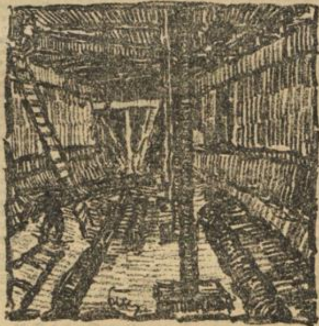
Etabau eines Deckenträgers Berliner Straße.
