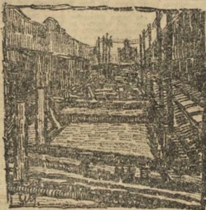
Tunneldecke in der Kleiststraße.
