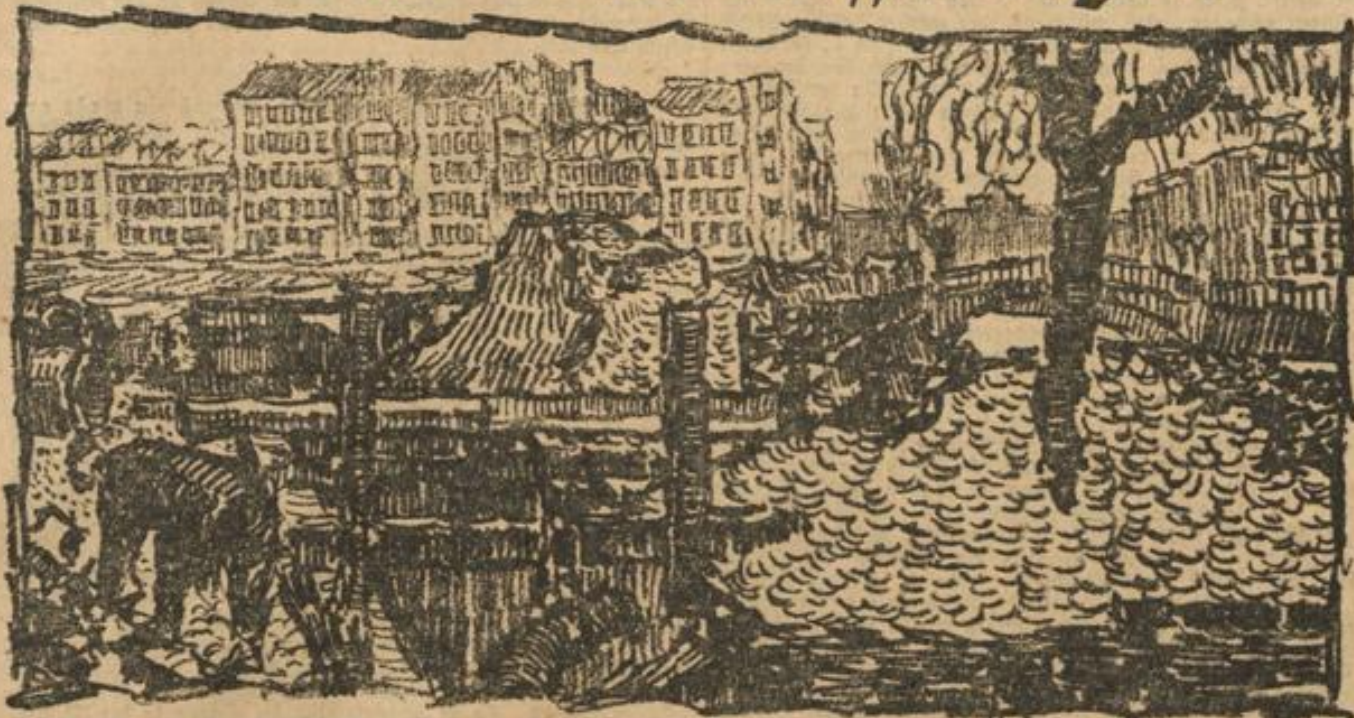
Das Kanalbett in der Zuschüttung.
