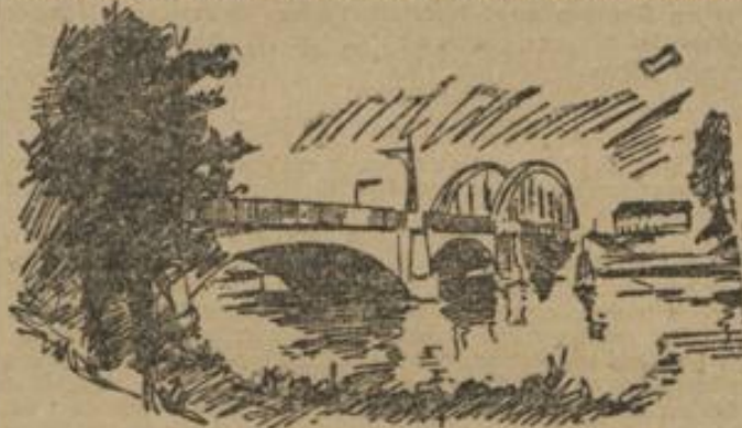
Brücke über die Spree.
