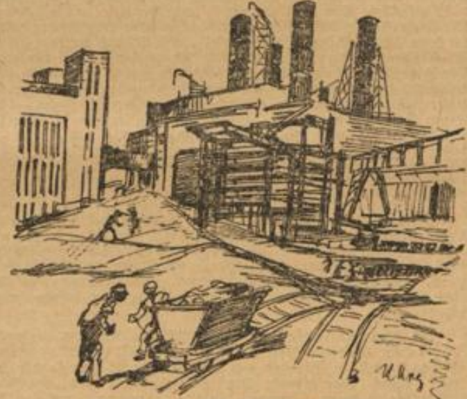
Der Neubau des Großkraftwerks.
