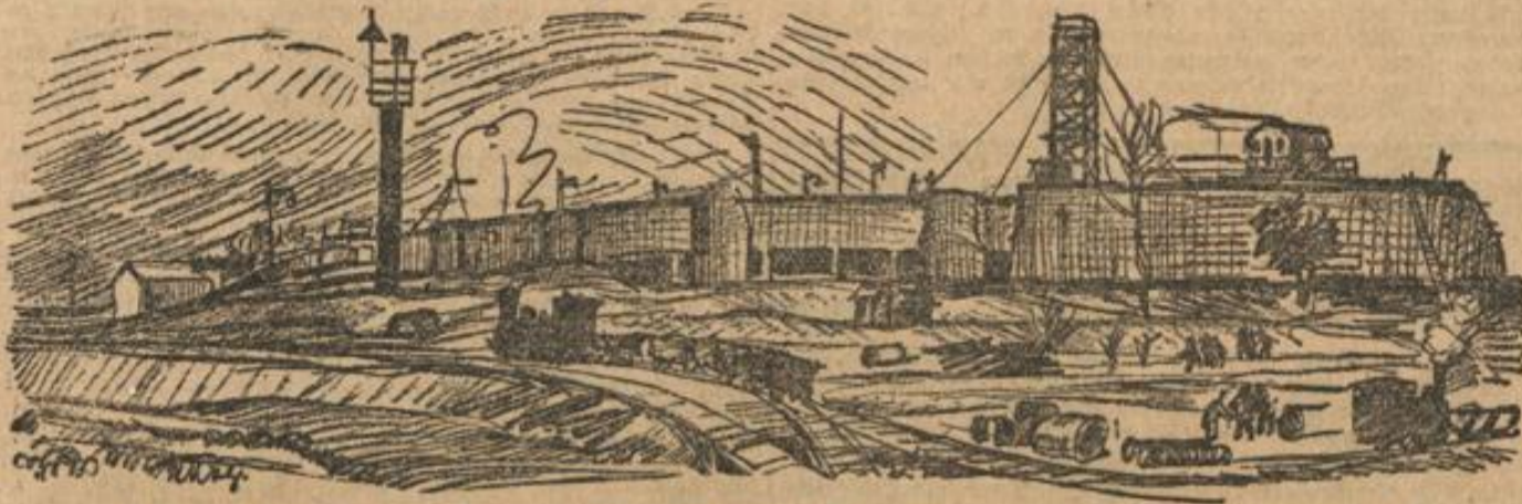
Die Neubauten der Vorkläranlagen zur Gasgewinnung in Waßmannsdorf.
