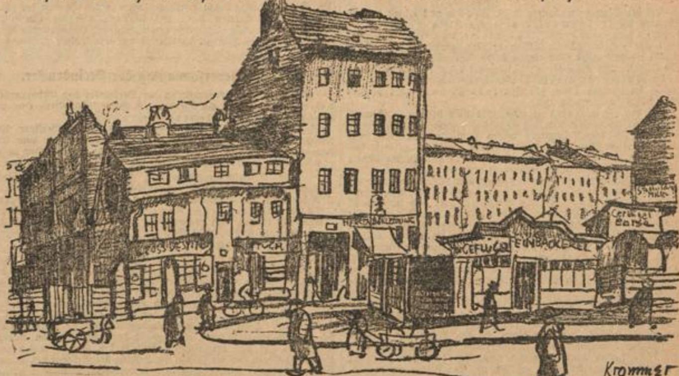
Reste des alten Scheunenviertels am Bülowplatz.
