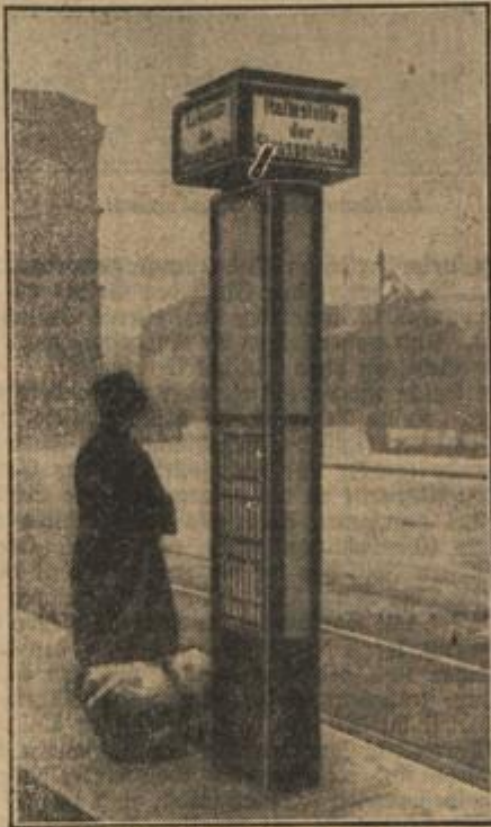
Die Berliner Straßenbahn macht seit einiger Zeit Versuche mit neuen, am Abend erleuchteten Haltestellensäulen.
