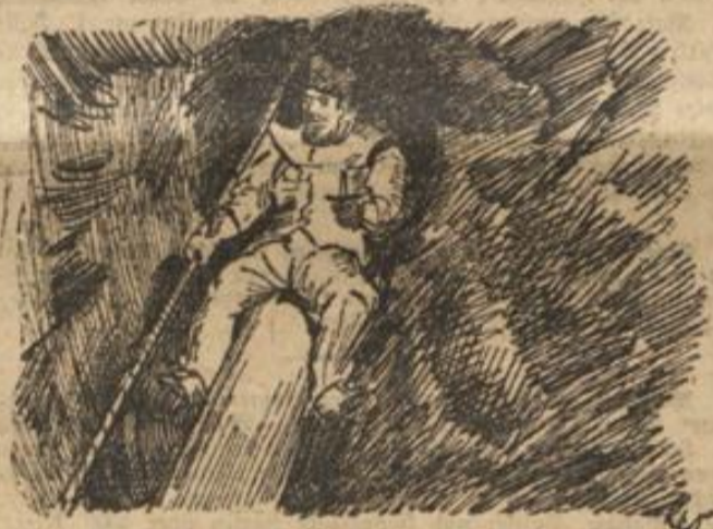
Alte „Fahrtkunst“. Auf dem Baumstamm in den Schacht.
