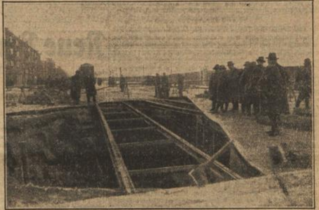
Die Einbruchstellen des Wassers in Tempelhof. — Die Straßenbahnschienen schweben in der Luft.
