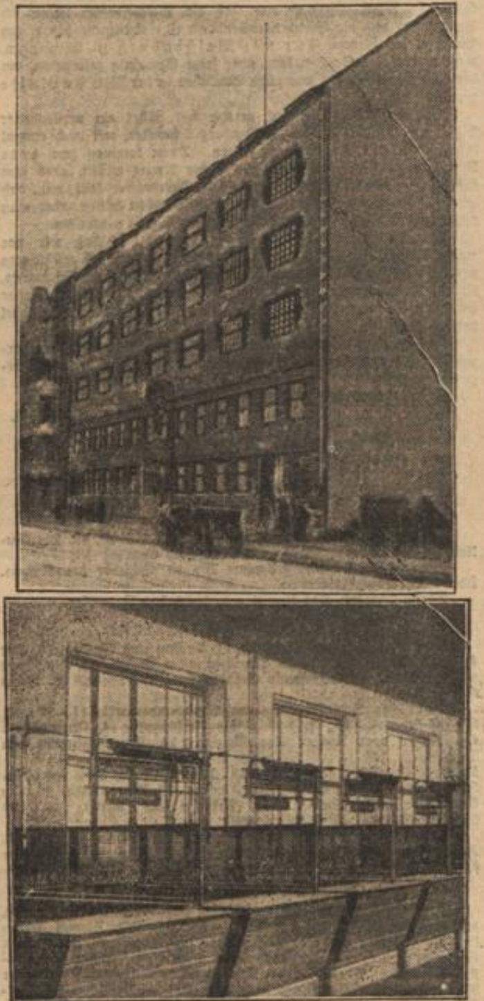
Das neue Grosspostamt N. 65 in der Gerichtstraße wird am Sonntag eröffnet. Schon das Äußere zeigt die Hand des modernen Banküblers. Kein behördlich gestempelter Stil kennzeichnet den Bau.
