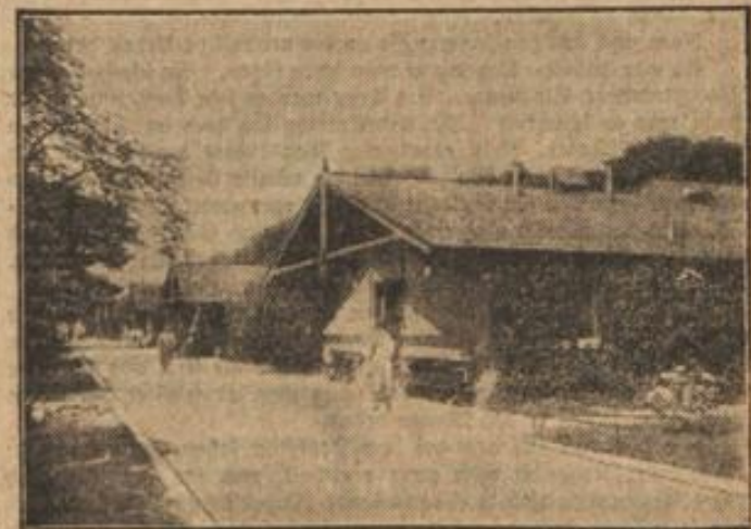
Dieser Tage beginnt der Abbruch der im Jahre 870 erbauten Cholerabaracken im Moabiter Krankenhaus; sie werden durch einen modernen Pavillon ersetzt.
