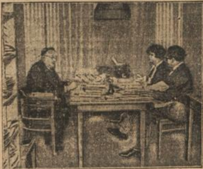
Das ist ein Arbeitszimmer.
