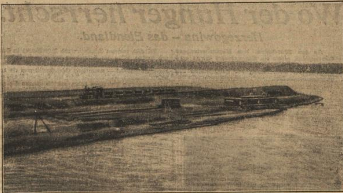
Der Damm von 800 m Länge und 50 m Breite ist schon bis zur Hälfte fertiggestellt. Die kleinere abgetrennte Wasserfläche soll Industriehafen werden, während der Damm selbst Hallenbad mit Badestrand und Strandpromenade erhält.
