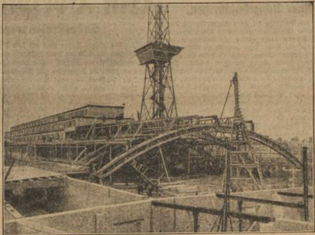
Auf dem großen Messegelände im Berliner Westen ist eine neue große Funkhalle im Bau.
