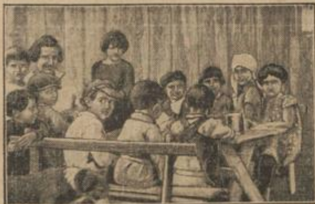
Im Kindergarten der Siedlung Hissin.
