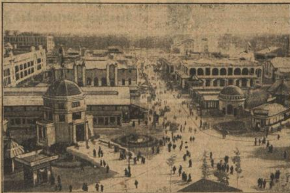
Das Ausstellungsgelände in Mailand, auf dem die Explosion erfolgte.
