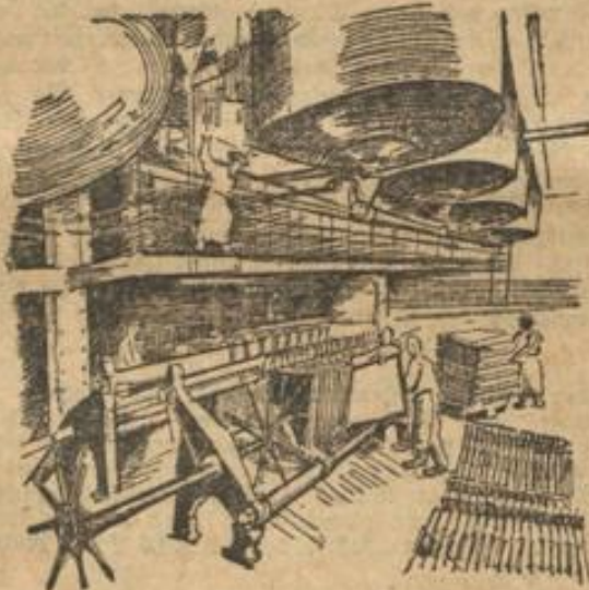
Seifenfabrik Gröba-Riesa: Plattenkühlmaschine
