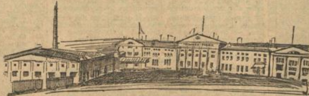
Ansicht der Teigwarenfabrik Gröba-Riesa
