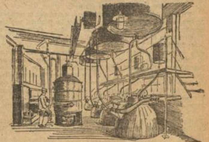
Seifenfabrik Gröba-Riesa: Fettsplaltungsanlage
