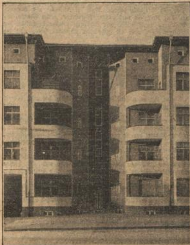
Paul-Heyse-Strasse, Treppenhaus und Balkone.
