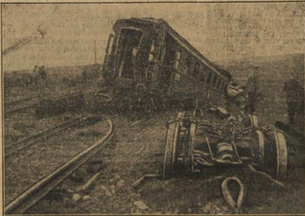
Bild 1: Das Fahrgestell der Lokomotive, das aller Wahrscheinlichkeit nach die Ursache der Entgleisung war. Es hat sich tief in das Erdreich gebohrt, während der Lokomotivkörper den Abhang hinunterstürzte. — Bild 2: Die Aufräumarbeiten an der Unglücksstelle mit Hilfe fahrbarer Kräne.
