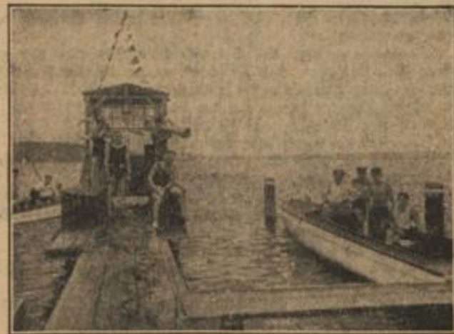
Die Rettungsstation des Freibades
