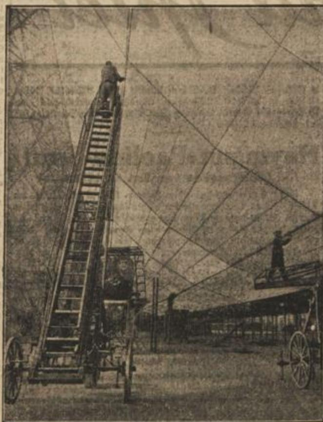
Der 235 m lange und 33,5 m hohe Luftschiffkörper, der 105 000 cbm Auftriebsgas fassen kann.
