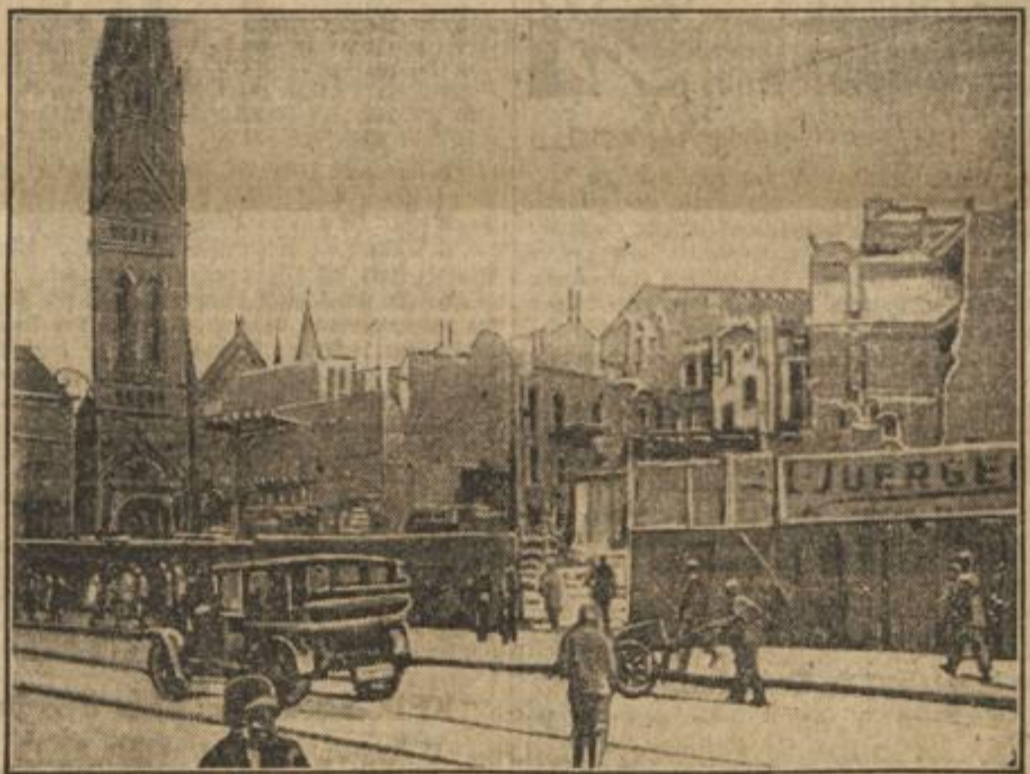
Die Gegend um den Alexanderplatz, der vollständig umgestaltet wird, gleicht infolge der zahlreichen Häuserabbrüche einem Feld moderner Ruinen.
