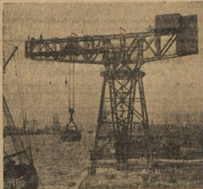
Dieser riesige Kran im Hafen von Dublin — ein Sinnbild moderner Transporttechnik — hat eine Tragfähigkeit von 100 000 Kilogramm und eine Ausladung von 23 Metern.
