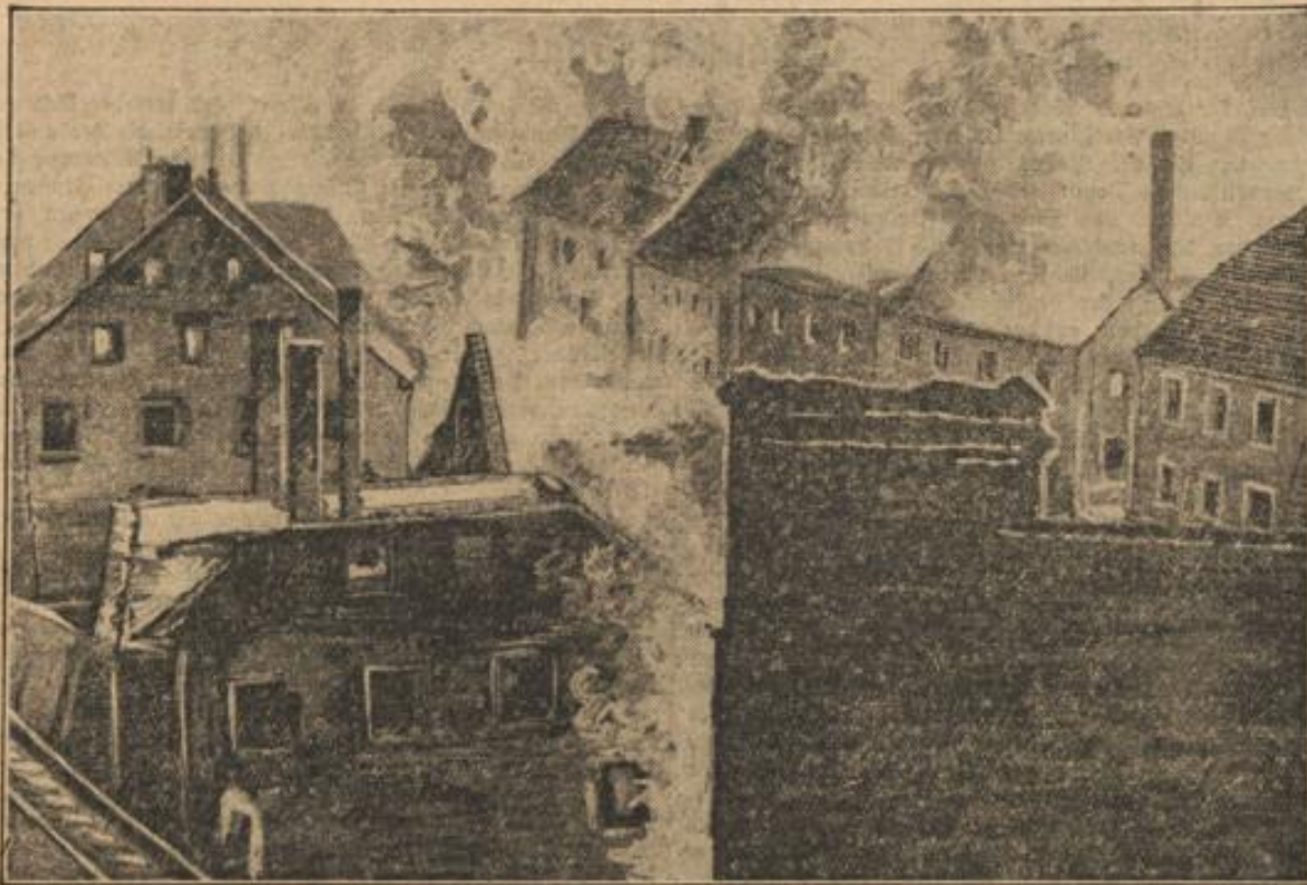
Ein Brandunglück verwüstete am Donnerstag nachmittag den Markflecken L u h e, der etwa 6 km von Weiden (Oberpfalz) entfernt liegt. Innerhalb kurzer Zeit wurden etwa 100 Wohnhäuser und Scheunen in Schutt und Asche gelegt.
