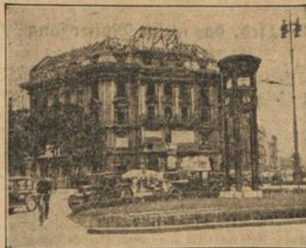
Das Hotel Bellevue am Potsdamer Platz wird jetzt abgerissen. Dadurch wird der Platz als Berliner Verkehrsbrennpunkt eine völlige Umgestaltung erfahren. Auf einem Teil des Grundstücks soll später ein Warenhaus errichtet werden.
