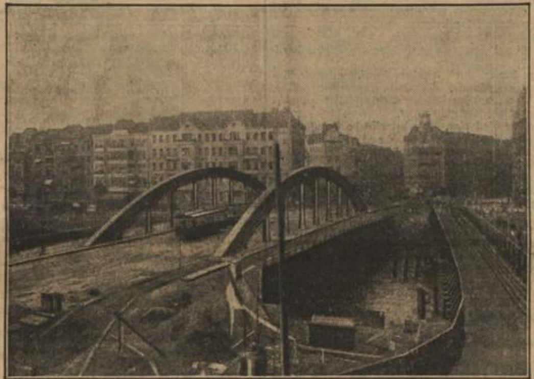
Nach zweijährigem Umbau ist die Brücke jetzt wieder für den Verkehr freigegeben worden.
