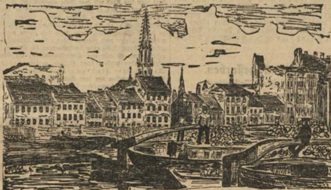
Berlins Romantik wird bald der Geschichte angehören. Die hier im Bilde wiedergegebenen Häuser an der Friedrichsgracht werden nicht mehr lange am Ufer der Spree stehen.
