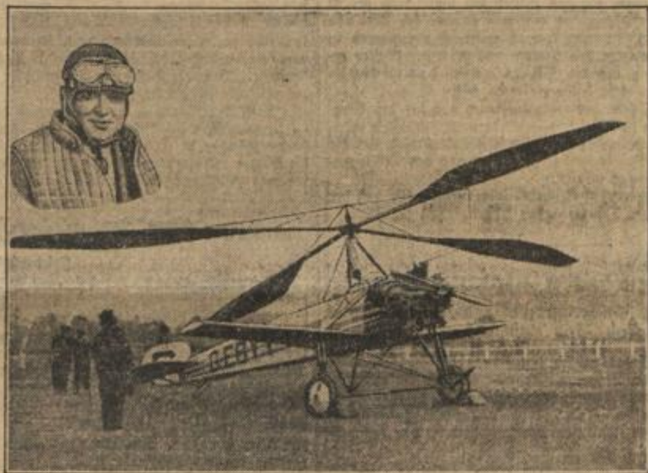
Der spanische Flieger La Cierva hat in dem von ihm konstruierten Schraubenflugzeug den Aermelkanal überquert und ist auf dem Flugplatz von Le Bourget gelandet. Der Apparat hat in geringer Höhe über dem Führersitz ein frei drehbares Flügelrad angebracht, das mit seinem Durchmesser von 25 Metern die gesamte Länge des Apparates um das Doppelte übertrifft. Durch diese Schraube ist es möglich, auf einer Fläche von nur fünf Metern zu starten und zu landen. Cierva hat seine ersten Flugversuche in Berlin unternommen.
