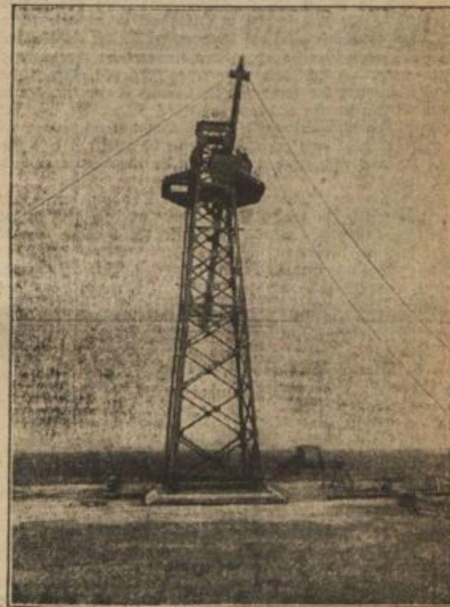
Auf dem Staakener Flugplatz geht ein neuer Ankermast seiner Vollendung entgegen. An diesem Ankermast soll „Groß Zeppelin“ anlegen, wenn er nach seiner Rückkehr aus Amerika in Staaken landen sollte.
