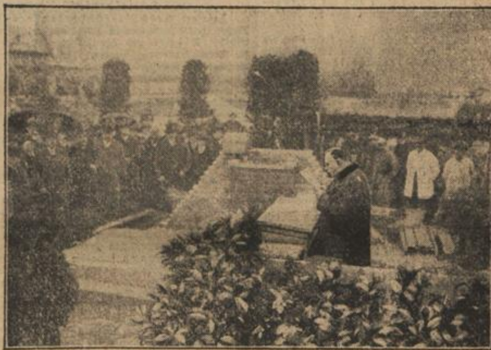
Bürgermeister Leids Ansprache bei der Grundsteinlegung.
