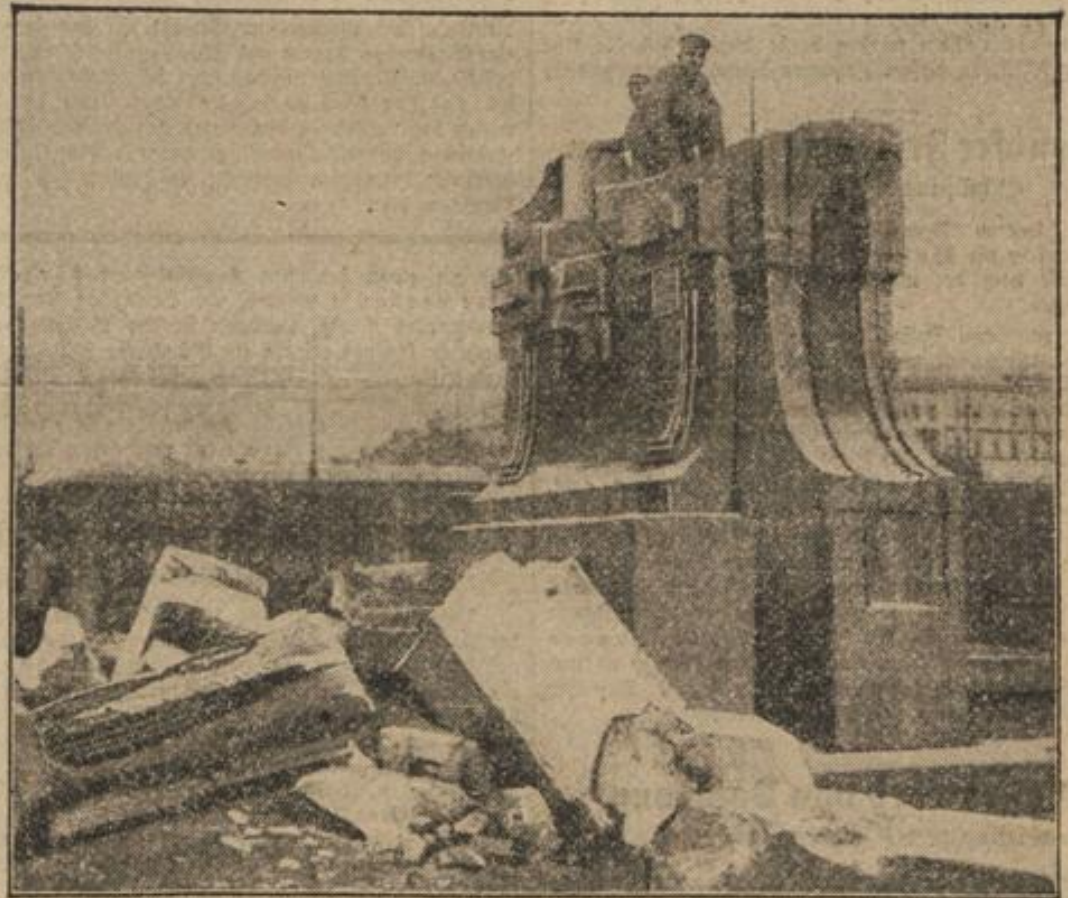
Die Zuschüttung des Luisenstädtischen Kanals wird wie manche andere auch die Oranienbrücke überflüssig machen. Mit ihr verschwinden auch die vier haushohen Steinkandelaber, die ihr ein besonderes Gepräge gaben. Der Abbruch der Candelaber ist in vollem Gange.
