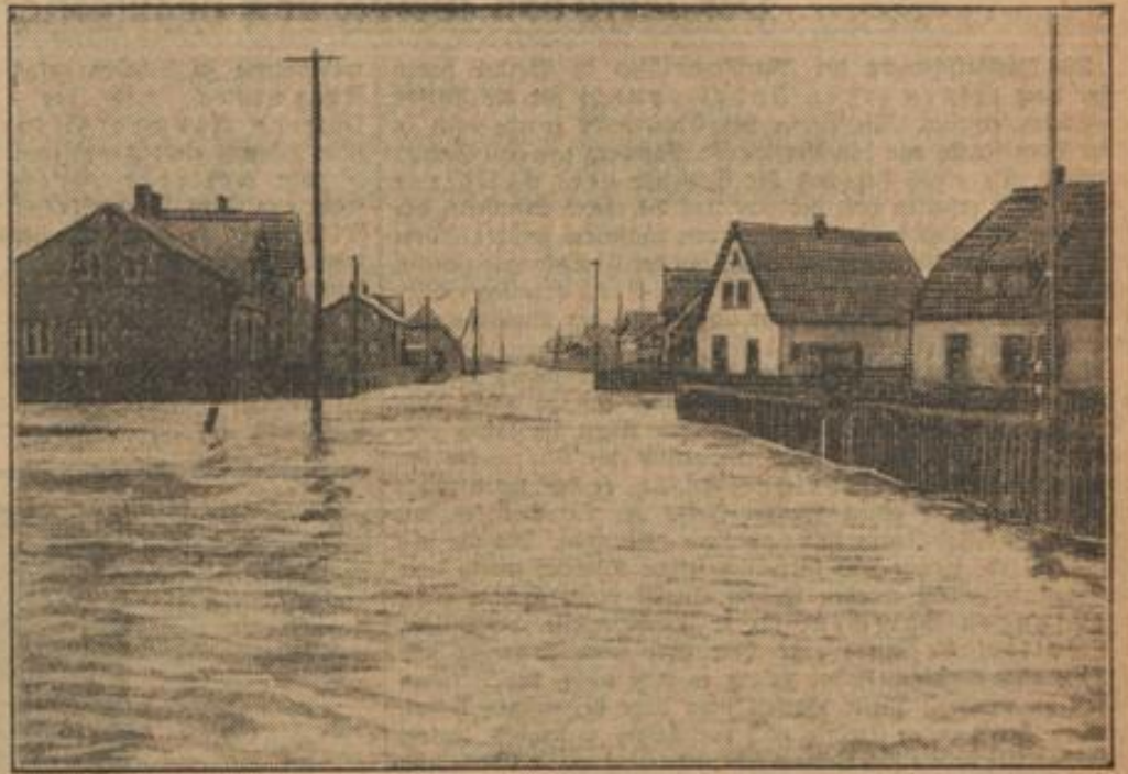
Eine überschwemmte Straße auf Sylt.
