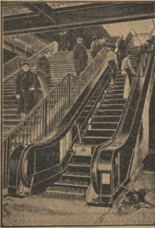
Die Rolltreppe auf dem neuen Berliner Stadtbahnhof „Ausstellung“ verbindet den Bahnsteg der Züge Grunewald-Spandau mit dem einen Stock höher gelegenen Bahnsteig der Ringbahn. Die erste Rolltreppe der Reichsbahn wird am 10. Dezember zu gleicher Zeit mit dem neuen in der Nähe des Ausstellungs- und Messeplatzes errichteten Bahnhof „Ausstellung“ in Betrieb genommen.
