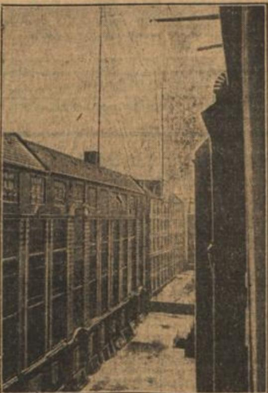
In Berlin ist ein zweiter Sender in Betrieb genommen worden. Er befindet sich auf dem Dach eines Gebäudes der Reichspost in der Borchgerner Straße. Der neue Sender soll dazu dienen, dem Osten Berlins einen besseren Rundfunkempfang zu ermöglichen. Die Wellen des Wiegeler-Senders werden nämlich trotz der Stärke dieser Station durch das Häusermeer der Großstadt so geschwächt, daß der Rundfunkempfang in Orien mit Detektorgeräten oft nicht mehr möglich ist.
