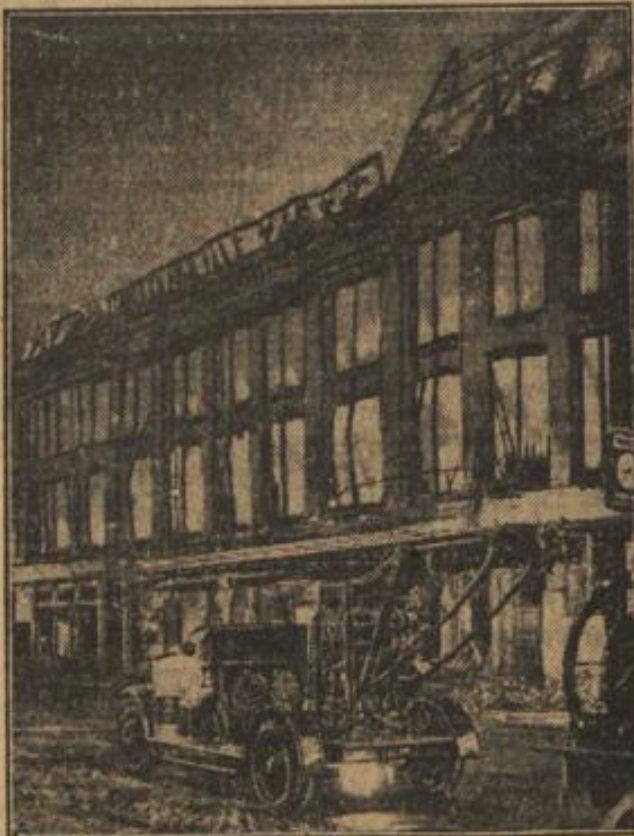
Das brennende Warenhaus.
