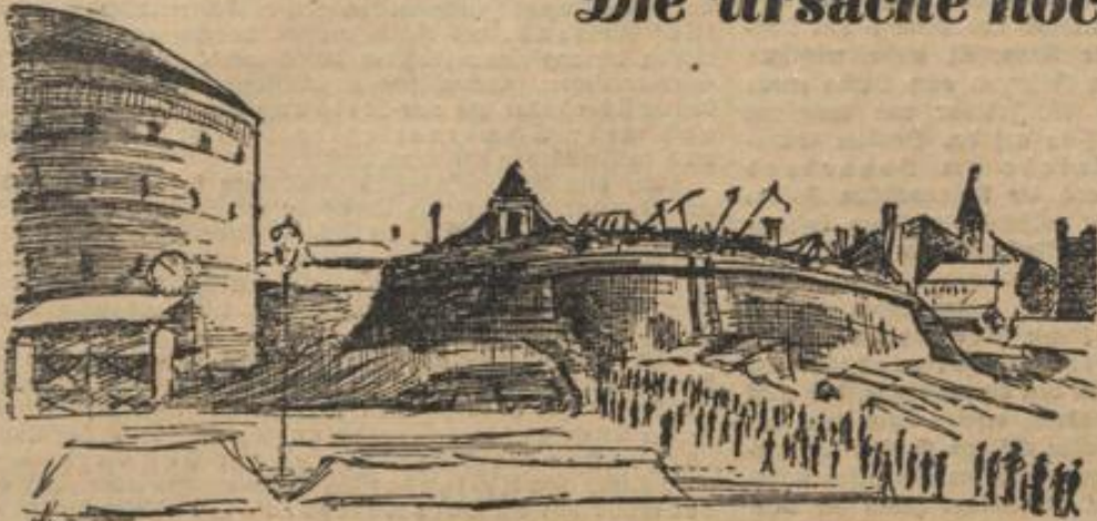
Die Ruine des explodierten Gasbehälters.
