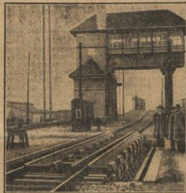
Unser Bild zeigt die von Dr. Baesler konstruierte „Wirbelstrombremse“, die von der Gesellschaft m. b. H. für Oberbauforschung auf Veranlassung der Deutschen Reichsbahn-Gesellschaft auf dem Bahnhof Magdeburg-Buckau zur Erprobung eingebaut wurde. Die beweglichen, parallel laufenden Bremschienen bilden Polschienen, die mit den Polschienen einer Anzahl von Elektromagneten zusammengefaßt sind. Die Kräfte werden von den Rädern der Fahrzeuge (massive Metallkörper) geschoben und rasen Wirbelströme hervor. Diese erzeugen eine Kraft, die entgegen der Fahrtrichtung wirkt, so daß durch den Einfluß des Wirbelstroms die Bremswirkung entsteht. Durch die Verdrehung der Kräfteflüsse an denjenigen Stellen, an denen sich die Radschienen zwischen den Bremschienen befinden, tritt auch eine magnetische Anpressung und damit eine Reibung zwischen Radschienen und Bremschienen ein. Die Bremswirkung setzt sich also zusammen aus einer Wirbelstromkraft und einer Reibungskraft. Die Steuerung der Bremswirkung erfolgt in einfacher Weise von einem hohen Bremsstern, der eine gute Uebersicht über den Ablauf und die Richtungsleistung bietet. Für den Rangierer liegt der Vorteil darin, daß das gefährliche Arbeiten mit den sonst üblichen Bremschienen wegfällt, da dies von Hand vor den anrollenden Wagen auf die Schienen gelegt werden mußten.
