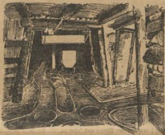
Gesteinstaubsperrung und Stapelschicht
