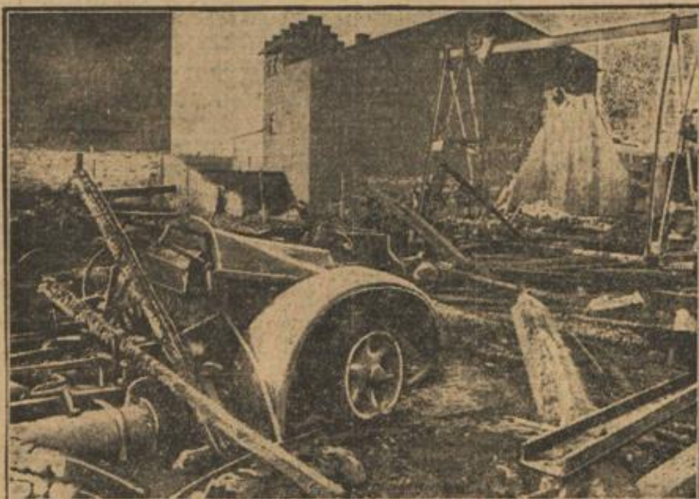
Das Kraftpostwerk in Borsigwalde wurde, wie berichtet, am Sonnabend von einem Großfeuer heimgesucht. Unser Bild zeigt die Trümmer der zerstörten Reparaturwerkstätten.
