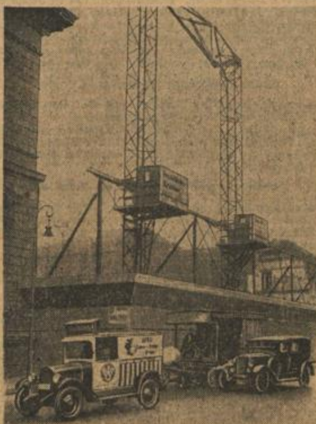
Der Neubau der Reichskanzlei.
