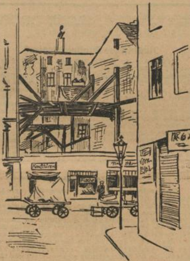
Zwei gestützte Häuser in der Grenadierstraße
