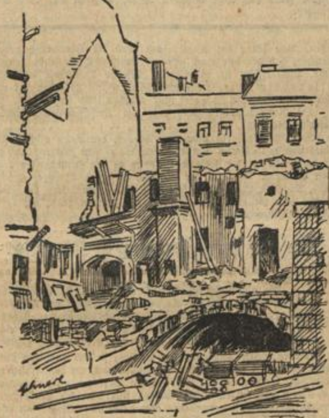
Abbruch in der Bartelstraße.
