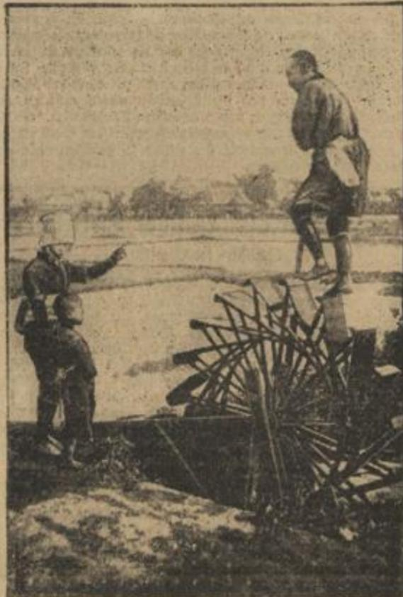
Zu den wichtigsten Frühjahrsarbeiten des japanischen Farmers gehört die Bewässerung seiner Reisfelder. Dies geschieht durch ein Wasserrad, das er wie seine Vorfäter immer noch durch Fußkraft betätigt. Das Wasser wird aus einem Teiche oder Flusse durch die Schaufeln des Rades in die Gräben geleitet, wenn der Farmer von einer Schaufel auf die andere tritt und so durch sein Gewicht als Antriebskraft dient.
