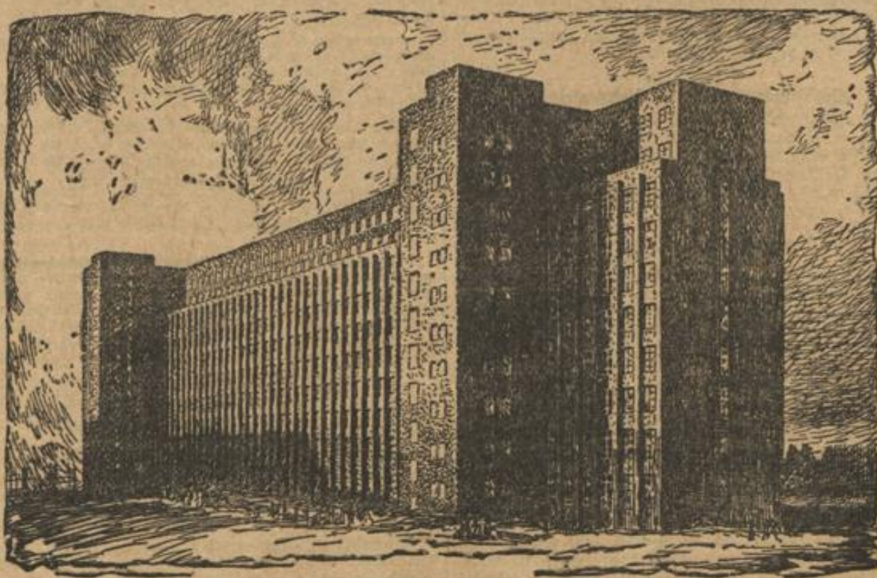
Der im vorigen Jahr vollendete Bau ist jetzt in seinem ganzen Umfange in Betrieb genommen worden. Die architektonische Erscheinung läßt klar den durch die Betriebserfordernisse bedingten baulichen Grundgedanken erkennen: Große durchlaufende beliebig unterteilbare Werkstätten in der starken räumlichen Konzentration eines Hochhauses; sämtliche Treppen, Aufzüge und Nebenräume in besonderen turmartigen Anbauten.
