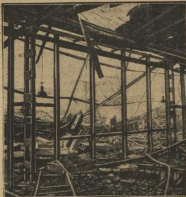
Aufräumungsarbeiten an der Brandstätte.
