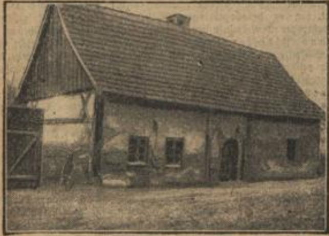
Baufälliges Wohnhaus einer Textilarbeiterfamilie in Peterswaldau (Besitzer Graf Stolberg-Ternigerode).
