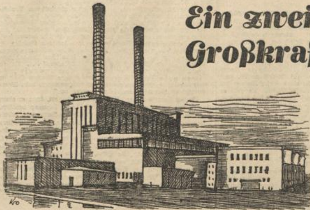
Unbild. Sechs Hauptmaschinen werden in diesem Spitzenkraftwerk je 34 000 Kilowatt erzeugen. Hinzukommen noch zwei Vorwärmer-turbinen von je 12 000 Kilowatt für die Deckung des Eigenbedarfes. Zwei Schornsteine, aber von erheblich größerem Umfang als die bekannten Klingenberg-Schornsteine, werden 120 Meter Höhe erreichen. Die Kessel erhalten Stoker-Feuerung. Der erste Bauabschnitt wird Herbst 1930, der zweite ein Jahr später vollendet sein.
