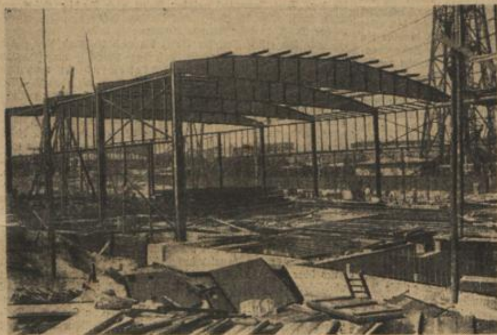
Die Messehallen im Bau
