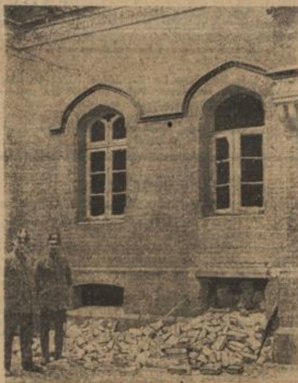
Die Sprengstelle in Lüneburg.
