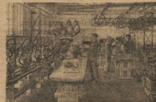
Fertigmontage der Motorräder I. Zusammenbau von Rahmen, Motor, hinterem Koischützer und Gepäckträger
