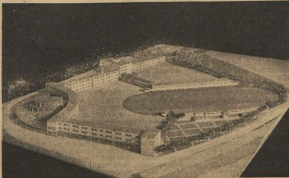
Der im Bau befindliche 3-Schulbau an der Schlichtallee.
