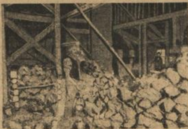
Inneres einer Schachthütte
