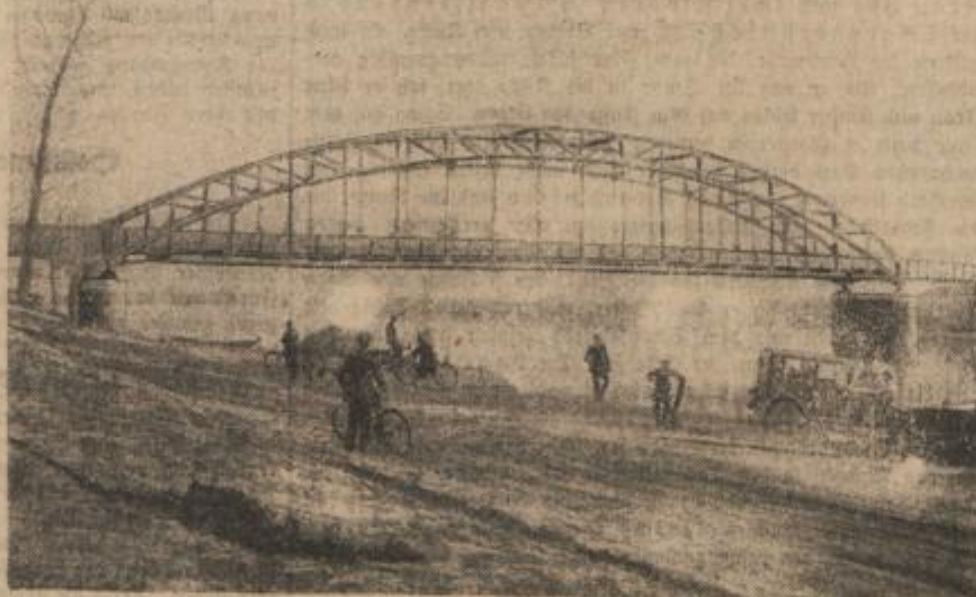
Die Fichtmerder Brücke zum Warthebruch.
